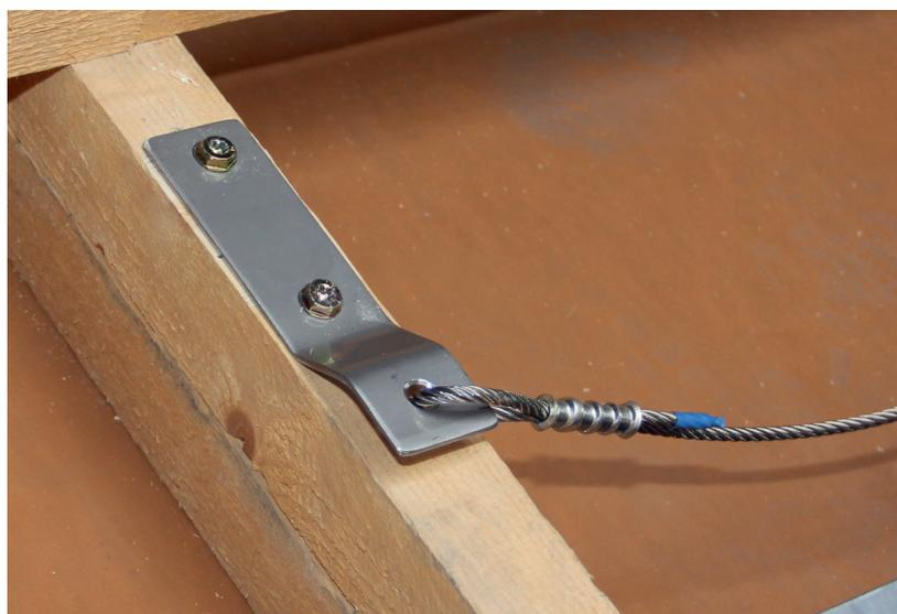
La plaque de base est fixée avec les deux vis à bois fournies à travers la contre-latte et les couches sous-jacentes dans les chevrons. Les couples de serrage du fabricant de vis doivent être respectés. Respecter une profondeur de vissage minimum de 100 mm dans les chevrons et une dimension minimum des chevrons de 60 × 120 mm. Si une sous-couche est pénétrée pendant le vissage, elle doit être correctement scellée.
