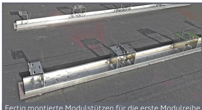
Fertig montierte Modulstützen für die erste Modulreihe
