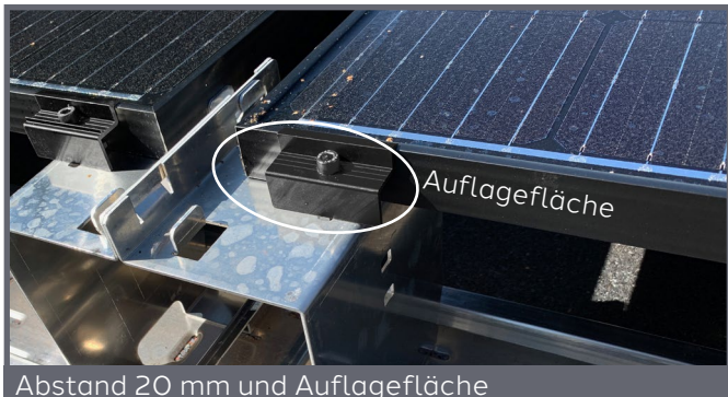
Auflegen des Photovoltaik-Moduls
