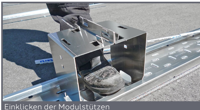
Ineinanderhaken der beiden hinteren Modulstützen
