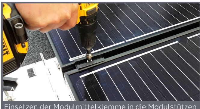
Einsetzen der Modulmittelklemme in die Modulstützen
