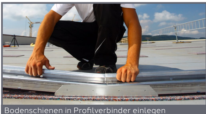
Bodenschienen in Profilverbinder einlegen
