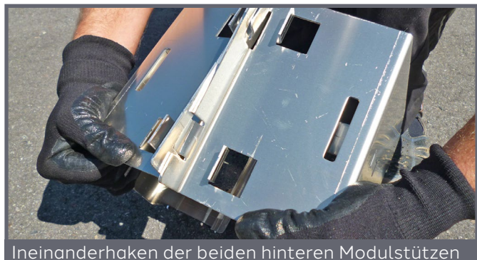
Einklicken der Modulstützen
