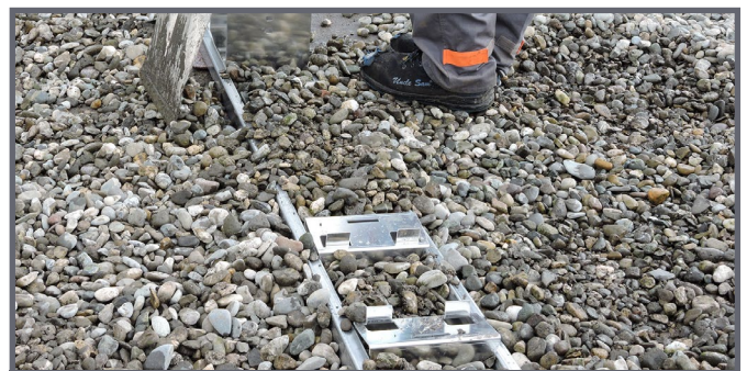
Ballastierung/Kies einbringen
