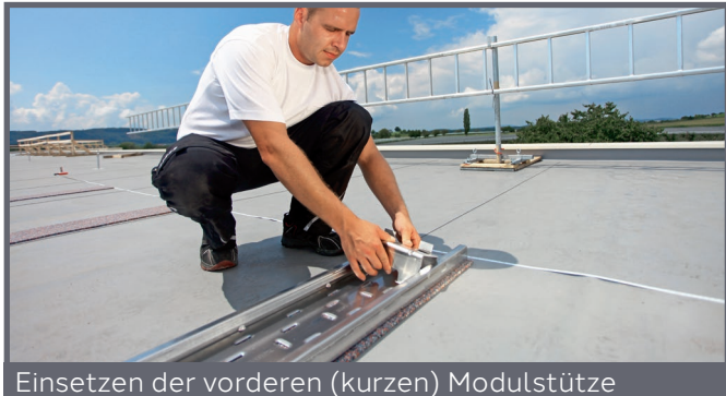
Einklicken der vorderen Modulstütze
