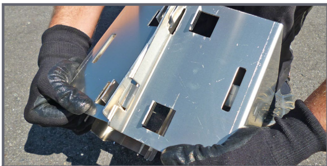
Ineinanderhaken der beiden hinteren Modulstützen
