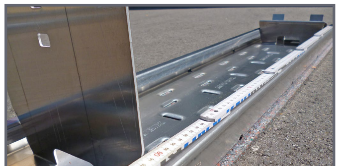
Einmessen der Modulstützen-Positionen
