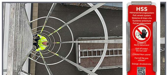
Das Warnschild muss am Dachzugang angebracht sein.
