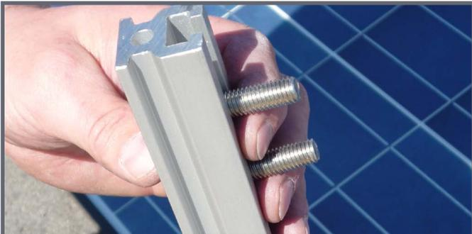
Einführen der Schrauben in die Laufschiene
