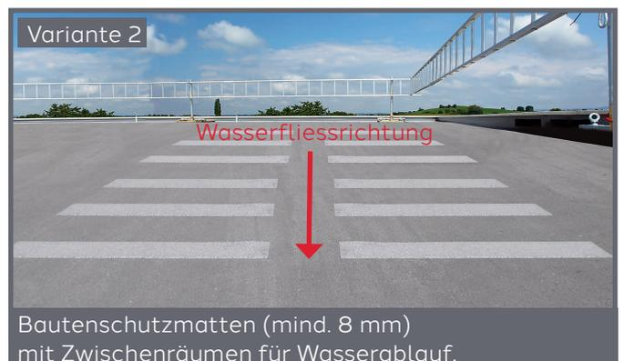
Bautenschutzmatzen (mind. 8 mm) mit Zwischenräumen für Wasserablauf.
