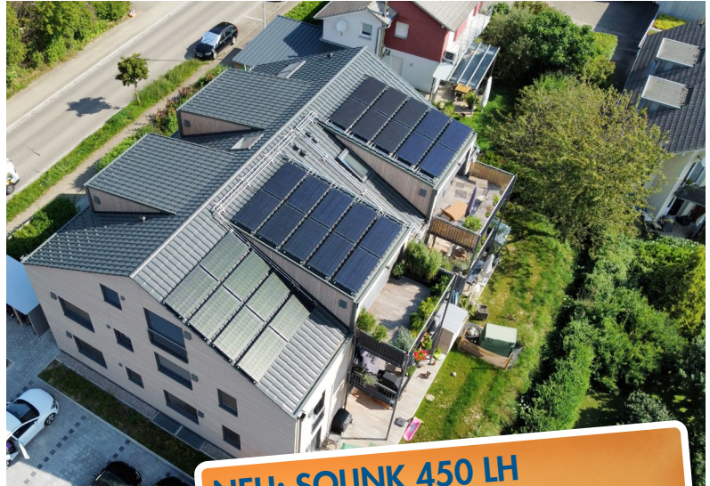
Mehrfamilienhaus mit 6 Wohnungen und einer 17 kW Wärmepumpe bei Freiburg
