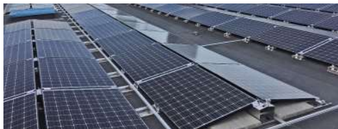
Système de montage EW Angle d'inclinaison de 10° Orientation est-ouest
