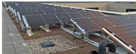
Système de montage GR Angle d'inclinaison de 10° / 15° / 20° Orientation sud
