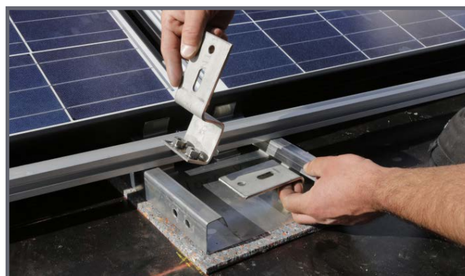
Placer le point de fixation avant dans le rail au sol
