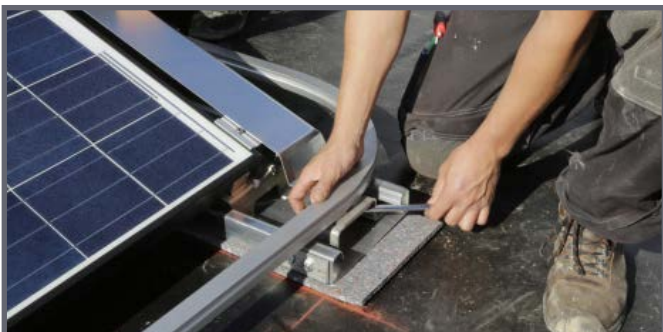
Fixer le rail de roulement
