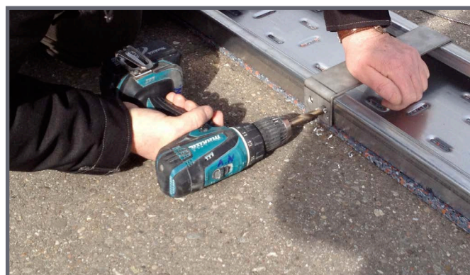
Utiliser le gabarit de perçage pour faire des trous dans les rails
