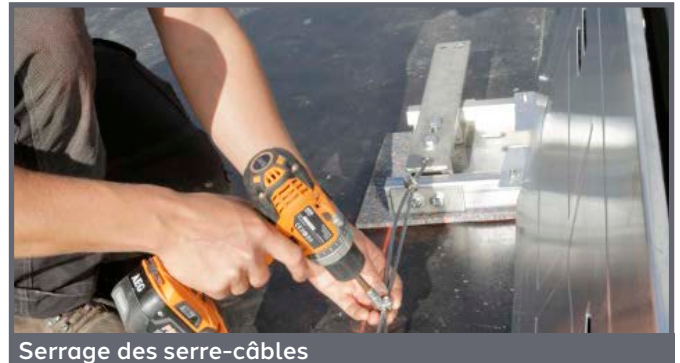
Système de câbles pour l'introduction de la charge dans le système
