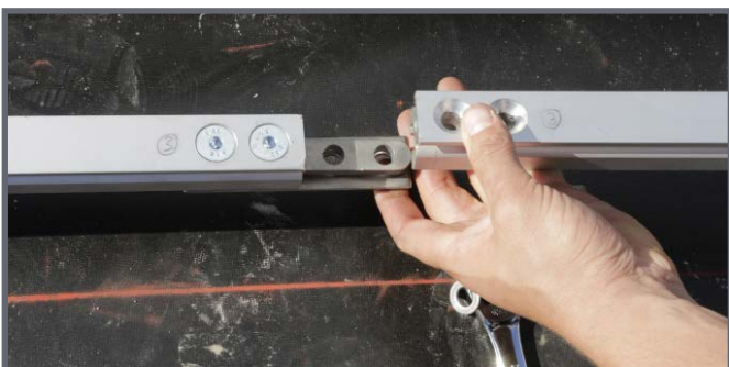
Relier les rails de roulement
