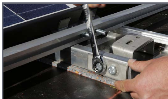
Placer la tôle de répartition de la charge et visser les vis !
