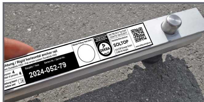
Anbringen des Typenschilds an jedem Einstieg
