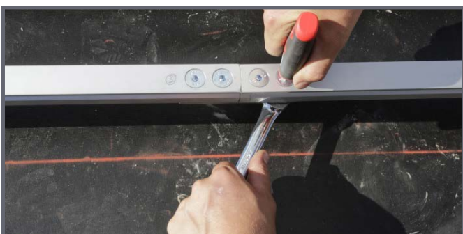
Schieneverbinder mit den vier Senkkopfschrauben
