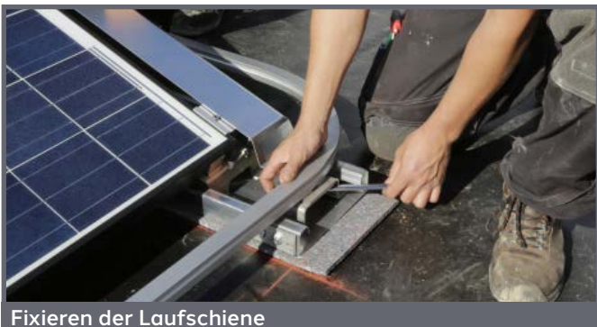
Fixieren der Laufschiene
