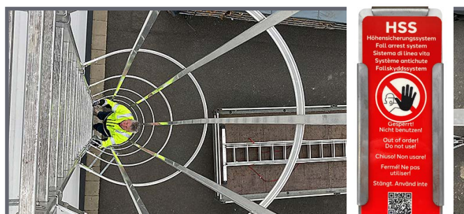
Das Warnschild muss am Dachzugang angebracht sein.
