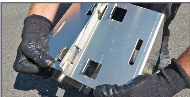
Ineinanderhaken der beiden hinteren Modulstützen
