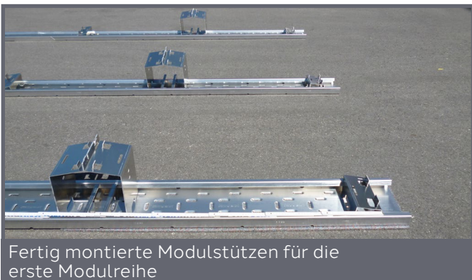
Die Befestigungsplatte ist ab 10° Dachneigung vorgeschrieben!
