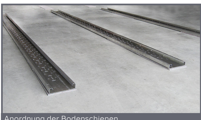
Anordnung der Bodenschienen
