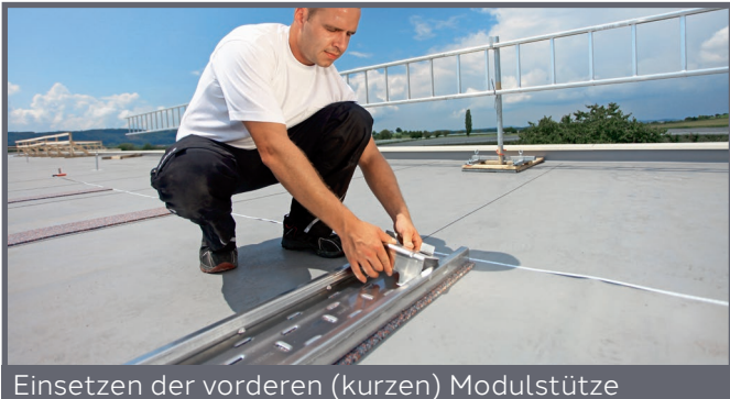
Einklicken der vorderen Modulstütze
