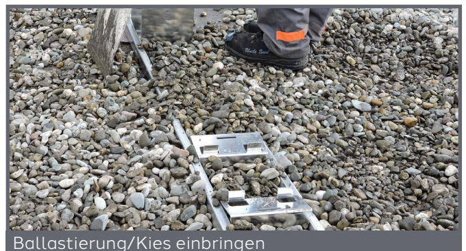
Ballastierung/Kies einbringen
