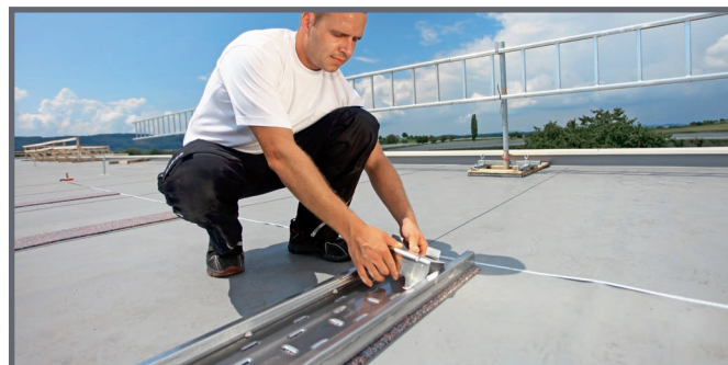
Encliquetage du support de module avant
