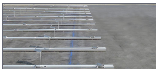
Supports de modules entièrement montés pour la première rangée de modules
