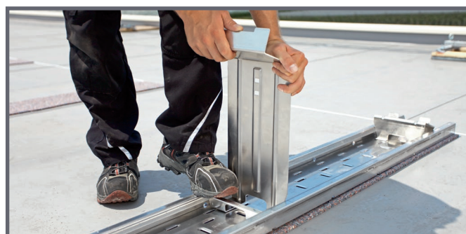
Encliquetage du support de module supérieur
