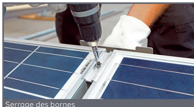
Serrage des bornes
