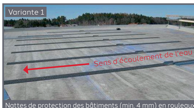
Mise en place des nattes de protection des constructions
