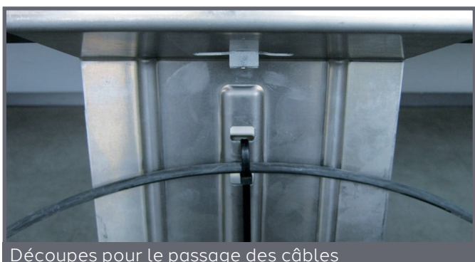
Découpe pour le passage des câbles
