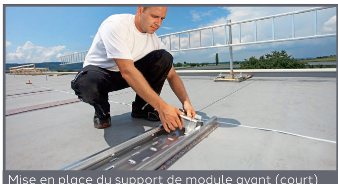
Mise en place du support de module avant (court)
