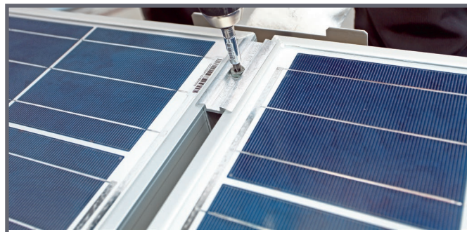
Serrage des bornes
