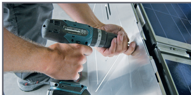
Visser ensemble les tôles de protection contre le vent en haut et en bas.
