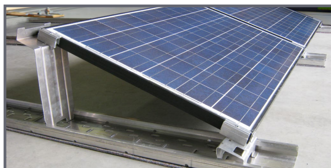
Première rangée de modules entièrement montée
