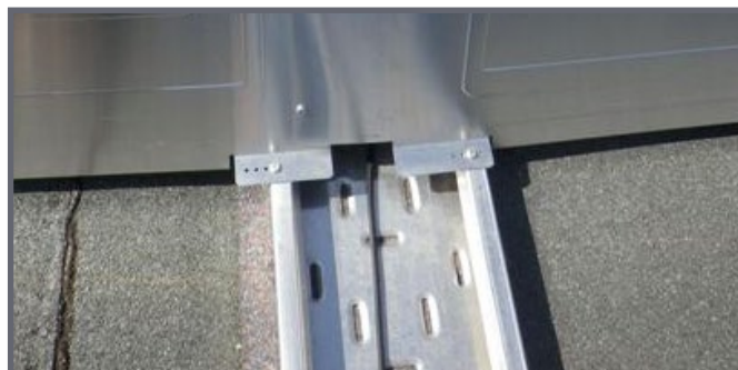
Tôles de protection contre le vent fixées au rail inférieur
