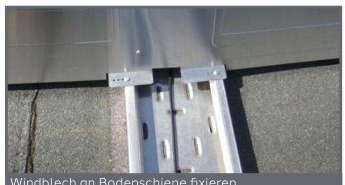
Windblech an Bodenschiene fixieren
