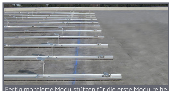
Fertig montierte Modulstützen für die erste Modulreihe
