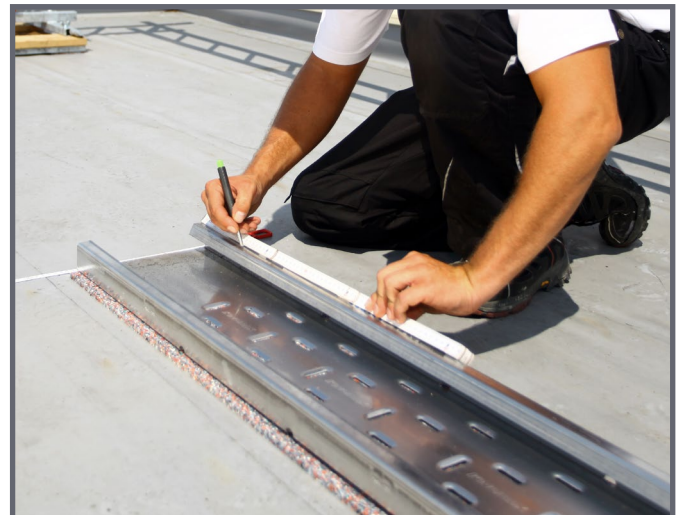
Einmessen der Modulstützen-Positionen
