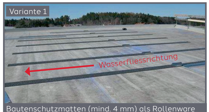
Auslegen der Bautenschutzmatzen
