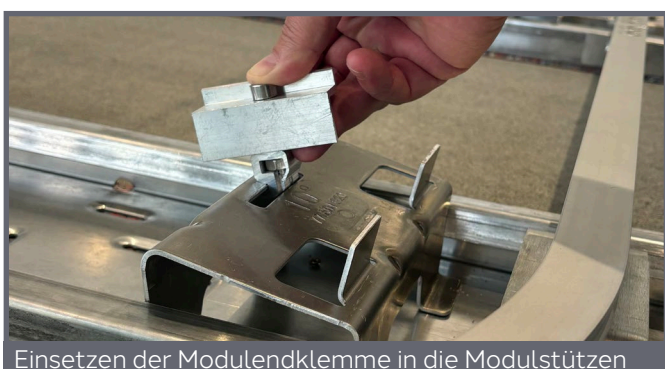
Einsetzen der Modulendklemme in die Modulstützen
