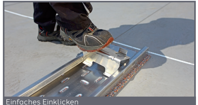
Einklicken der vorderen Modulstütze
