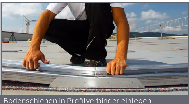
Bodenschienen in Profilverbinder einlegen
