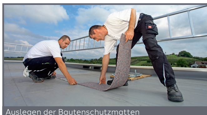
Auslegen der Bautenschutzmatzen
