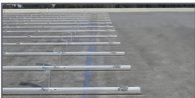
Fertig montierte Modulstützen für die erste Modulreihe
