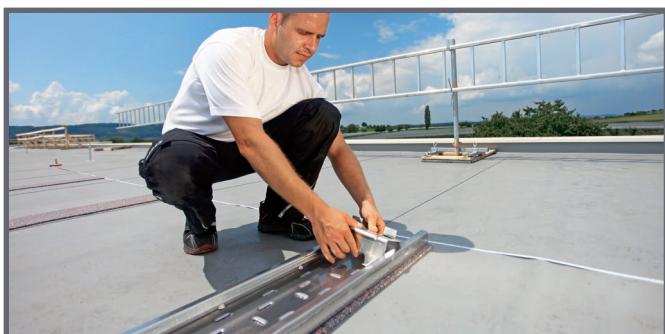
Einsetzen der vorderen (kurzen) Modulstütze
