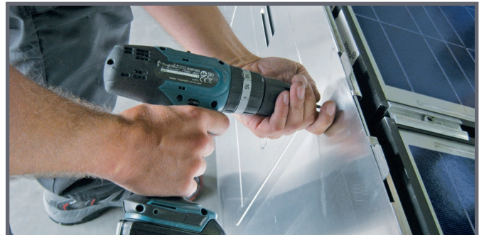
Windbleche oben und unten zusammenschrauben.
