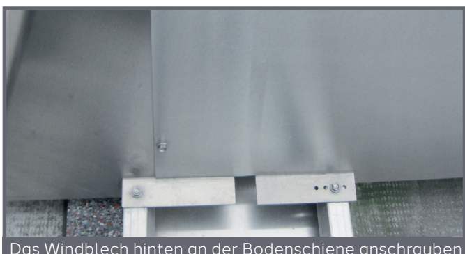
Das Windblech hinten an der Bodenschiene anschrauben
