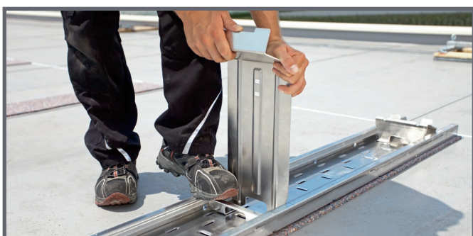
Einklicken der oberen (hohen) Modulstütze
