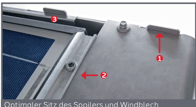
Optimaler Sitz des Spoilers und Windblech
