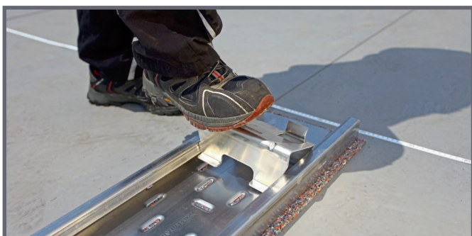
Einklicken der vorderen Modulstütze
