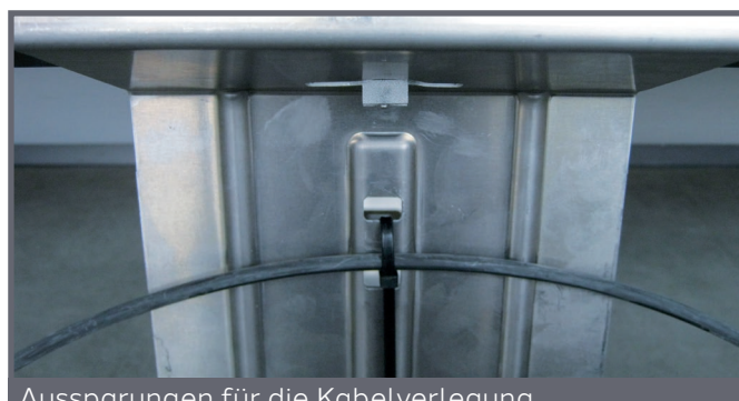
Aussparungen für die Kabelverlegung
