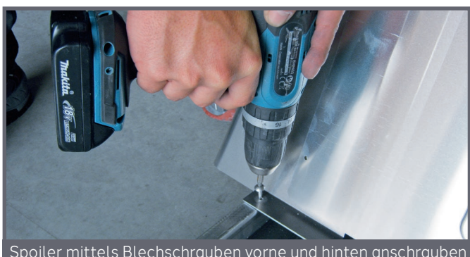
Spoiler mittels Blechschrauben vorne und hinten anschrauben
