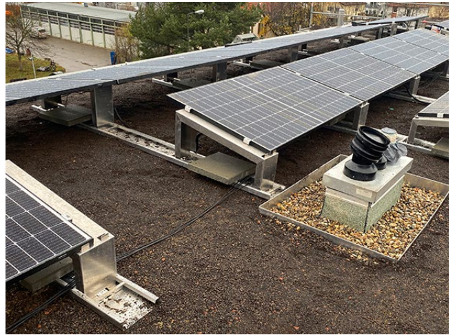
GR 10° en élévation est-ouest en A
