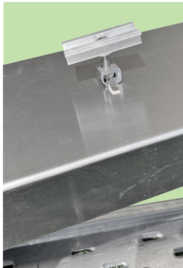
Duraklick-Mittelklemmen einsetzen, die Nase vom Klemmenfuß zeigt nach oben.
