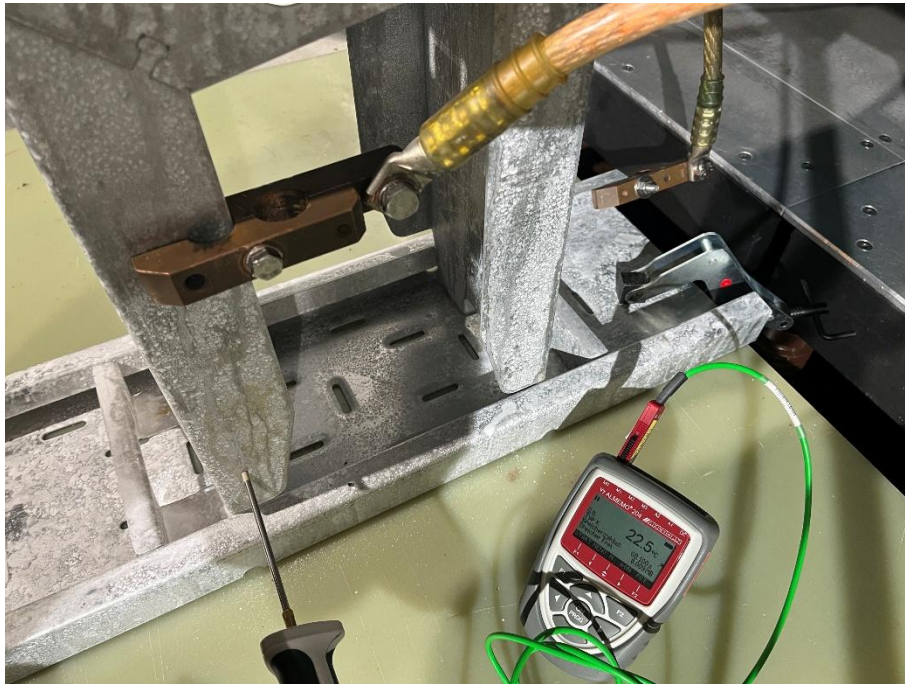
Bild 14: Temperaturmessung am Verbindungsbauteil Leiter 1.
