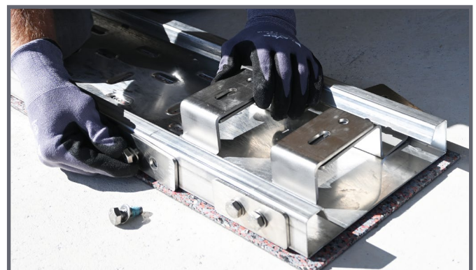
Leichtes Verschrauben der Befestigungspunkte
