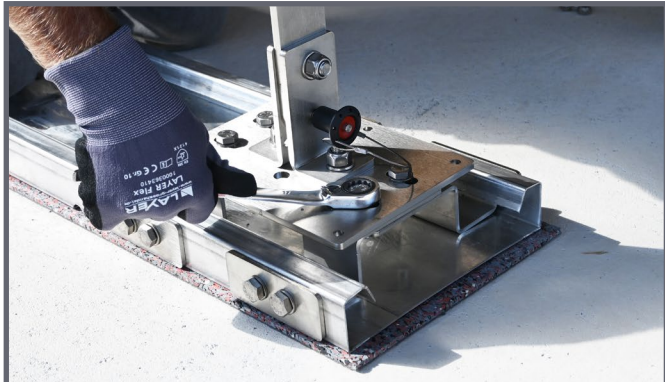
Positionierung der Grundplatte und Anschrauben
