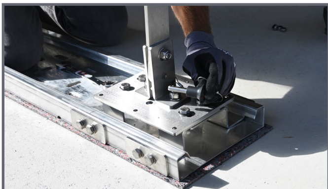
Sicherungsstift entfernen
