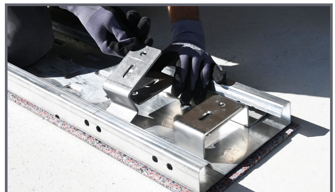
Die Befestigungspunkte in Bodenschiene einsetzen
