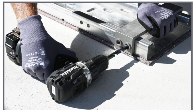
Mit Bohrschablone Löcher in Bodenschienen bohren
