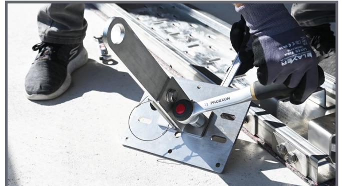
Lösen der beiden Schrauben des EAP
