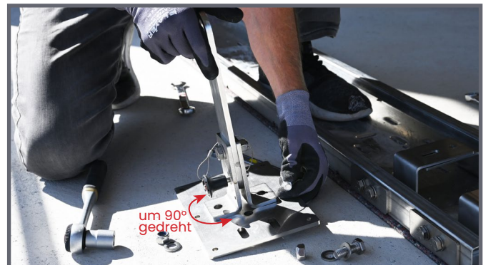
EAP um 90° drehen und auf Grundplatte verschrauben
