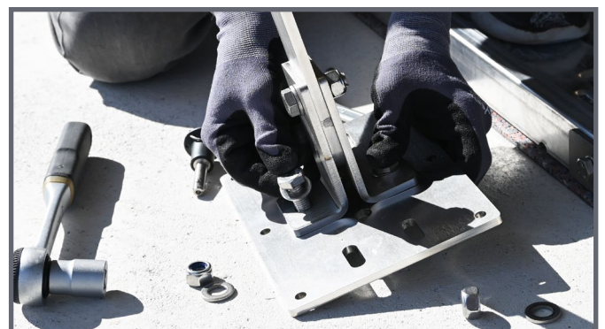
EAP auf Grundplatte festschrauben
