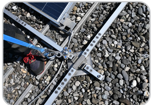
optional: Mitlaufendes Auffanggerät + Bandfalldämpfer
