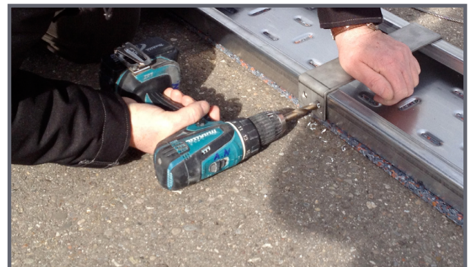
Mit Bohrschablone Löcher in Bodenschienen setzen
