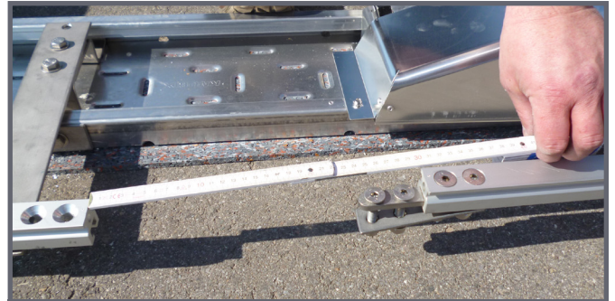
Fehlende Pass-Stücke ausmessen und zuschneiden
