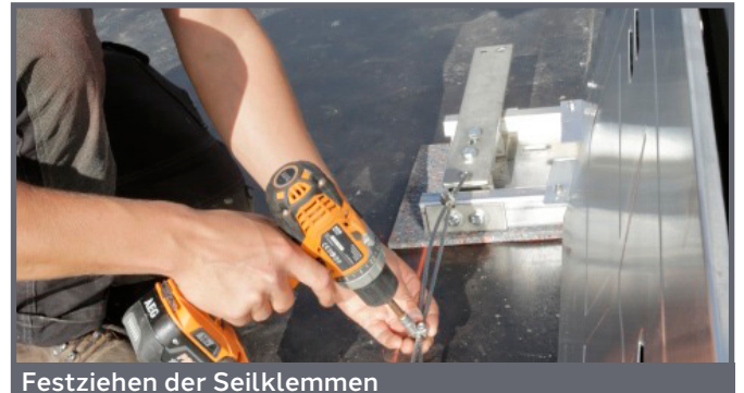
Seilsystem zur Lasteinleitung in das System
