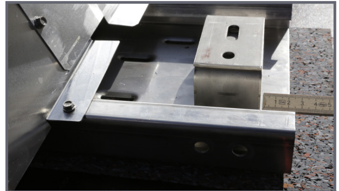
Abstand von min. 20 mm zum Bodenschienen-Ende
