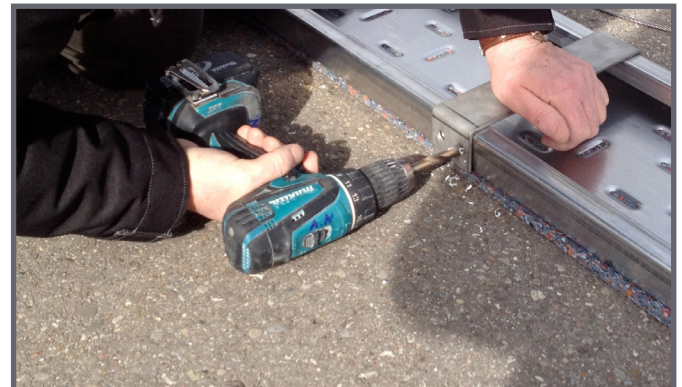
Mit Bohrschablone Löcher in Bodenschienen setzen
