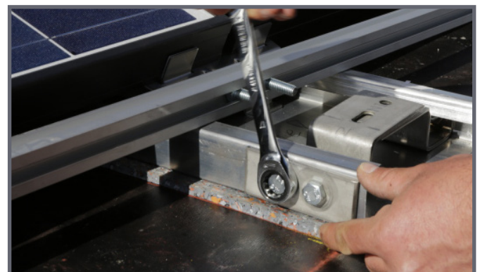
Lastverteilungsblech ansetzen und Schrauben eindrehen!
