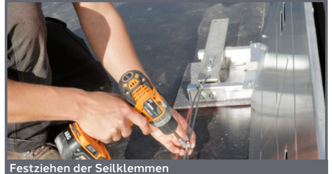
Seilsystem zur Lasteinleitung in das System
