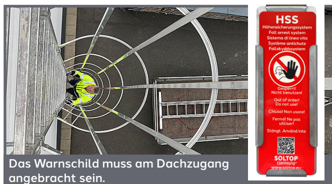
Anbringen des Typenschilds an jedem Einstieg
