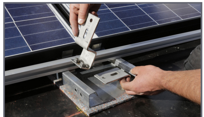
Vorderen Befestigungspunkt in Bodenschiene setzen
