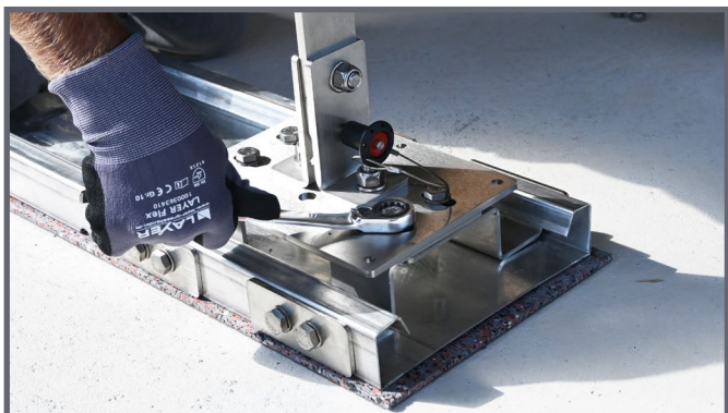
Position de la plaque de base et vissage
