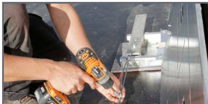
Serrage des serre-câbles
