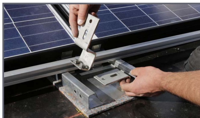
Placer le point de fixation avant dans le rail au sol
