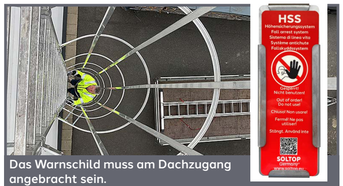
Anbringen des Typenschilds an jedem Einstieg
