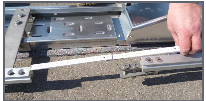
Fehlende Pass-Stücke ausmessen und zuschneiden
