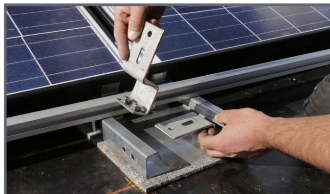
Vorderen Befestigungspunkt in Bodenschiene setzen
