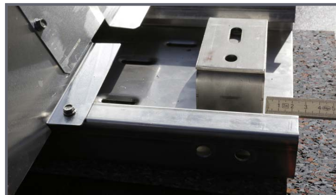
Abstand von min. 20 mm zum Bodenschienen-Ende
