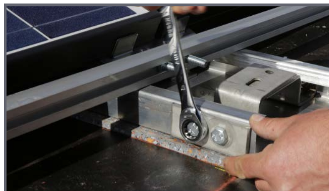
Lastverteilungsblech ansetzen und Schrauben eindrehen!
