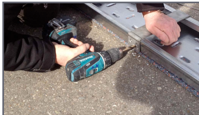
Mit Bohrschablone Löcher in Bodenschienen setzen
