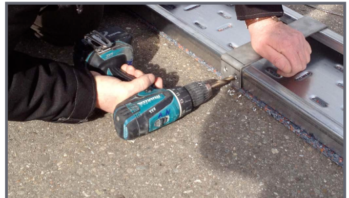
Mit Bohrschablone Löcher in Bodenschienen setzen
