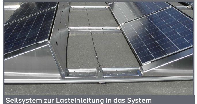
Seilsystem zur Lasteinleitung in das System
