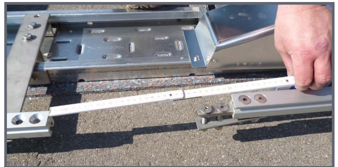
Fehlende Pass-Stücke ausmessen und zuschneiden
