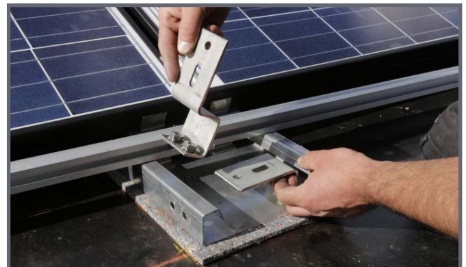
Vorderen Befestigungspunkt in Bodenschiene setzen
