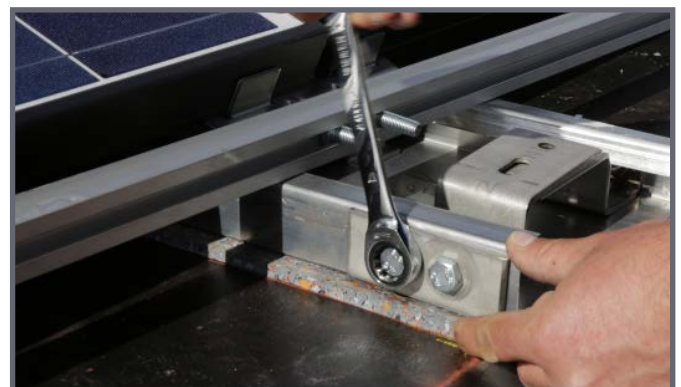
Lastverteilungsblech ansetzen und Schrauben eindrehen!
