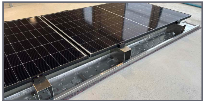
Fertig montierte erste Modulreihe
