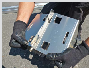
Zwei Stützen „Standard“ ergeben ineinander-gehakt eine!
