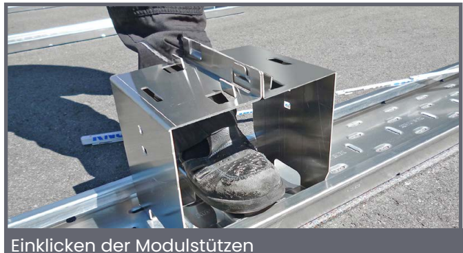
Einklicken der Modulstützen
