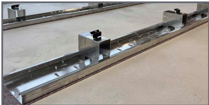
Fertig montierte Modulstützen für die erste Modulreihe
