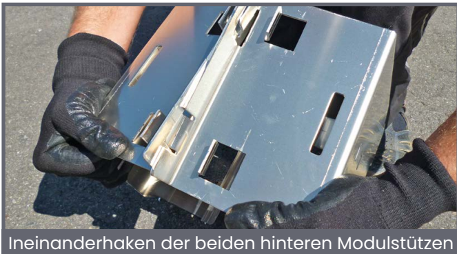
Einklicken der Modulstützen
