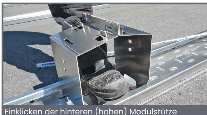
Ineinanderhaken der beiden hinteren Modulstützen
