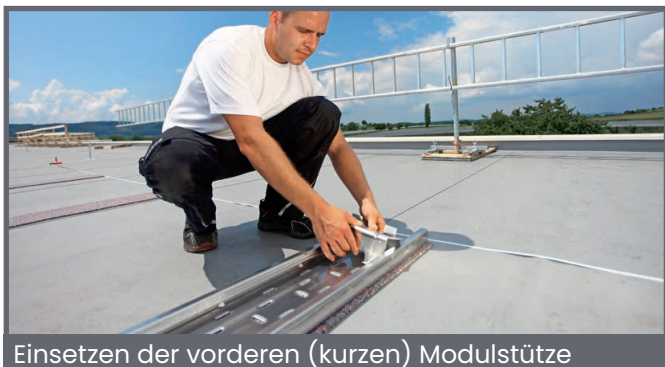
Einklicken der vorderen Modulstütze
