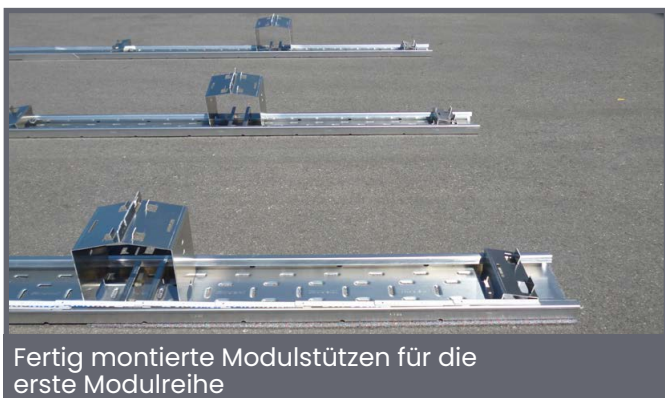
Die Befestigungsplatte ist ab 10° Dachneigung vorgeschrieben!
