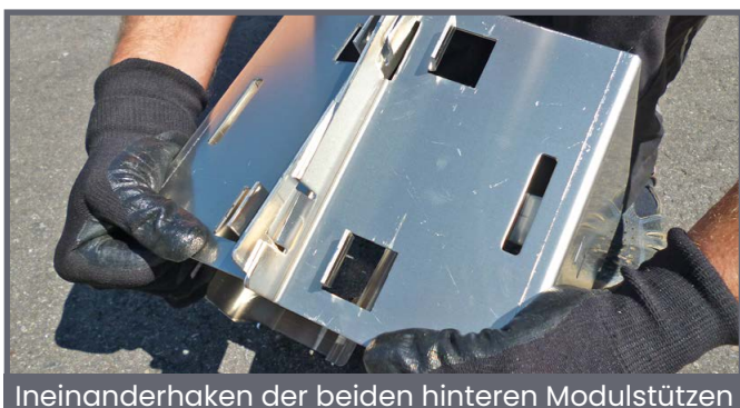
Einklicken der hinteren (hohen) Modulstütze
