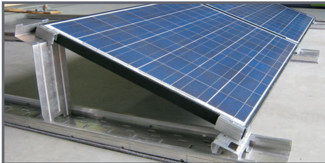
Première rangée de modules entièrement montée
