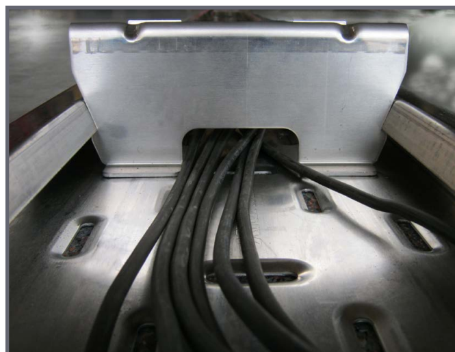
Rail utilisé comme chemin de câbles pour les câbles de chaîne
