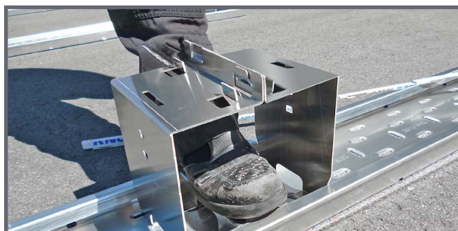
Encliquetage des supports de modules
