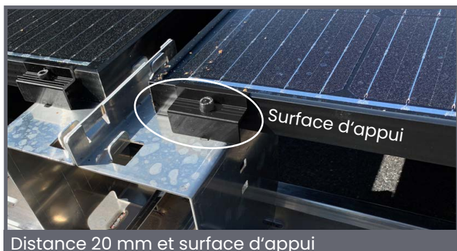
Poser le module photovoltaïque
