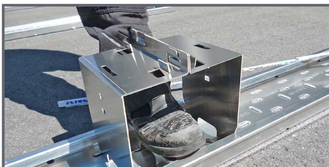
Encliquetage des supports de modules
