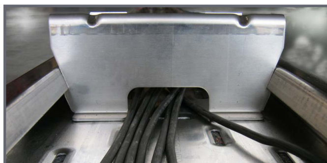
Rail au sol utilisé comme goulotte pour câbles de string
