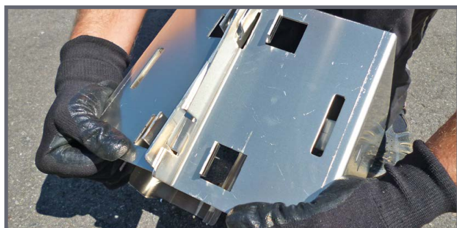
Accrochage des deux supports de module arrière l'un à l'autre
