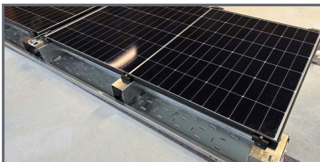
Première rangée de modules entièrement montée
