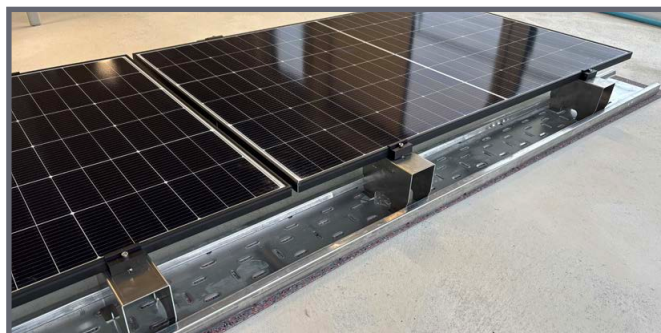
Première rangée de modules entièrement montée
