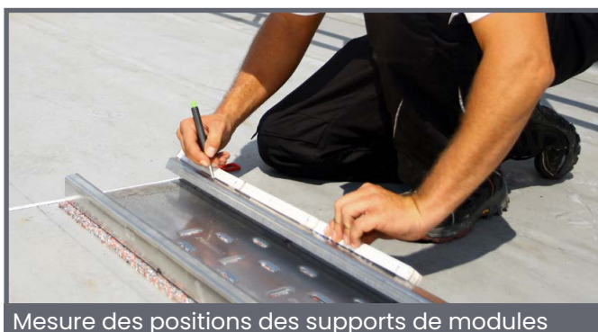
Rail au sol utilisé comme goulotte pour câbles de string
