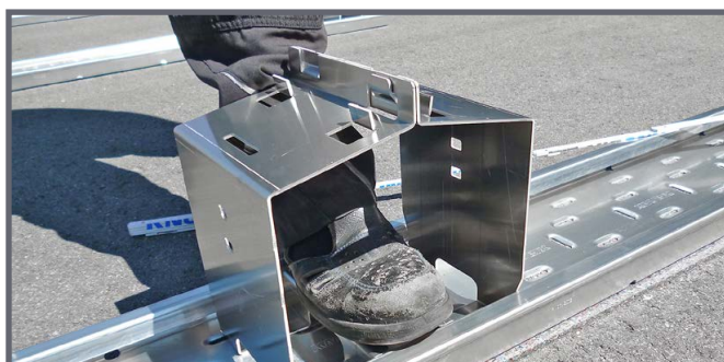
Encliquetage du support de module arrière (haut)
