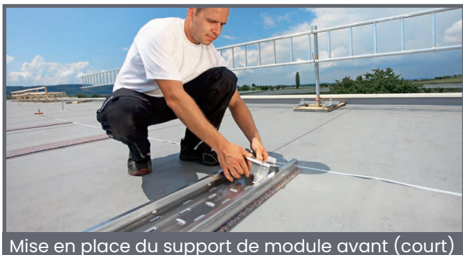
Encliquetage du support de module avant
