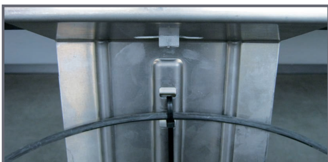
Découpe pour le passage des câbles
