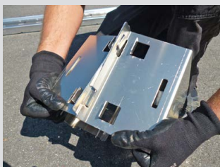
Deux supports de module supérieur accrochés l'un à l'autre donnent un support entier !
