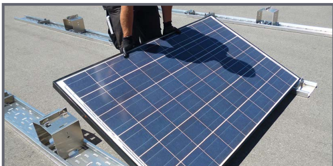
Mise en place du module photovoltaïque
