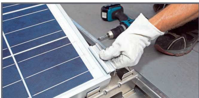
Insertion de la pince centrale de module dans les supports de module
