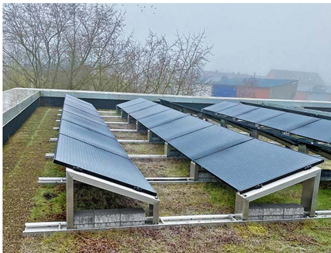
GR 20° en élévation est-ouest
