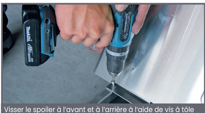
Positionnement optimal du spoiler et de la tôle anti-vent
