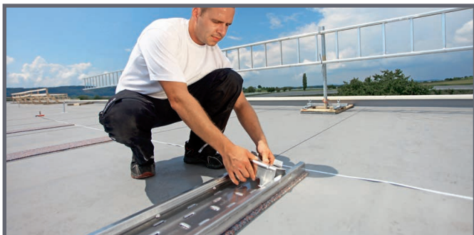
Mise en place du support de module avant (court)
