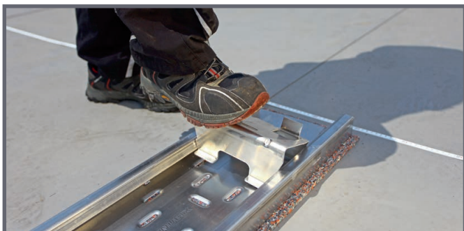
Encliquetage du support de module avant
