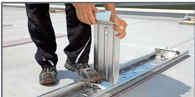
Encliquetage du support de module supérieur (haut)
