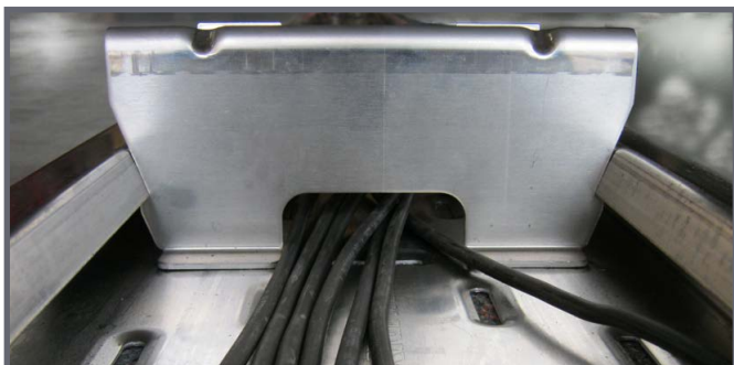
Rail au sol utilisé comme chemin de câbles pour les câbles de chaîne
