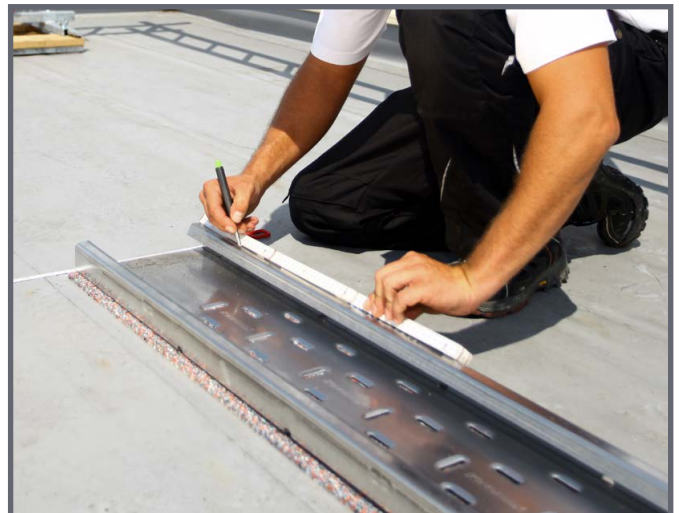
Einmessen der Modulstützen-Positionen
