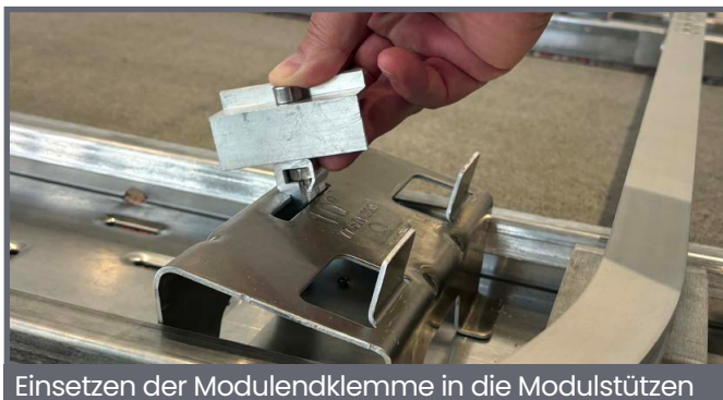
Einsetzen der Modulendklemme in die Modulstützen
