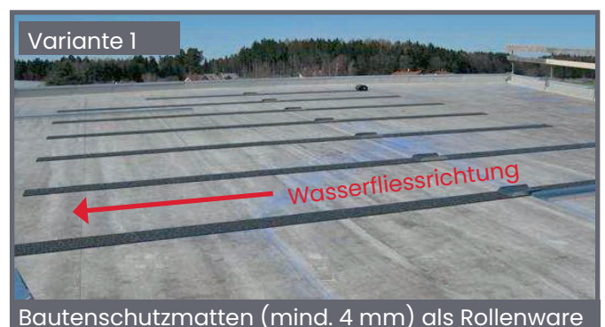
Auslegen der Bautenschutzmatzen
