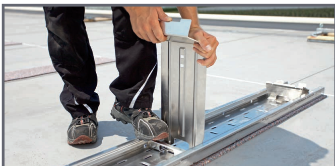
Einklicken der oberen (hohen) Modulstütze
