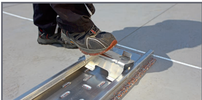
Einklicken der vorderen Modulstütze
