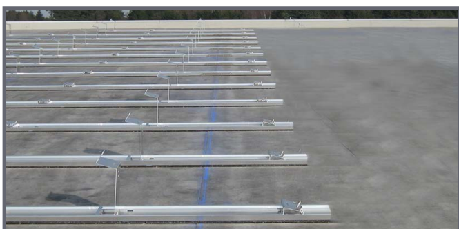
Fertig montierte Modulstützen für die erste Modulreihe
