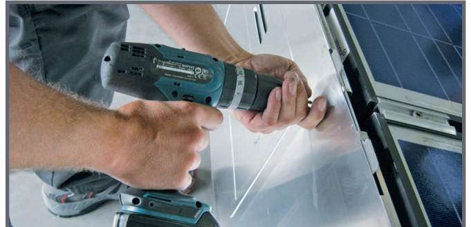
Windbleche oben und unten zusammenschrauben.
