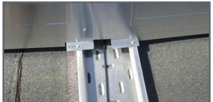
Windbleche an Bodenschiene fixiert
