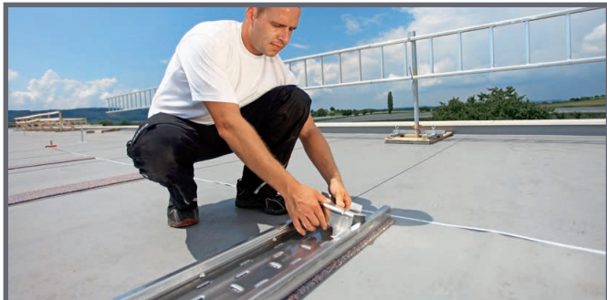
Einsetzen der vorderen (kurzen) Modulstütze
