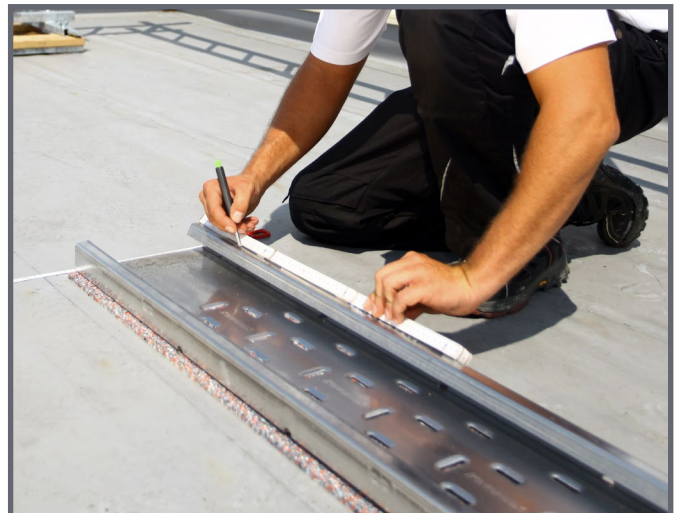
Einmessen der Modulstützen-Positionen
