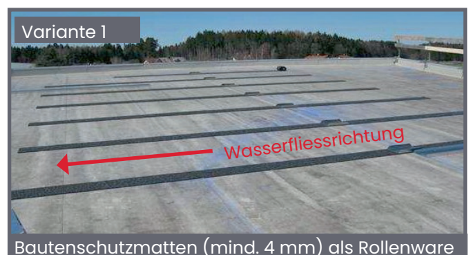
Auslegen der Bautenschutzmatzen
