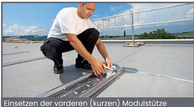
Einklicken der vorderen Modulstütze
