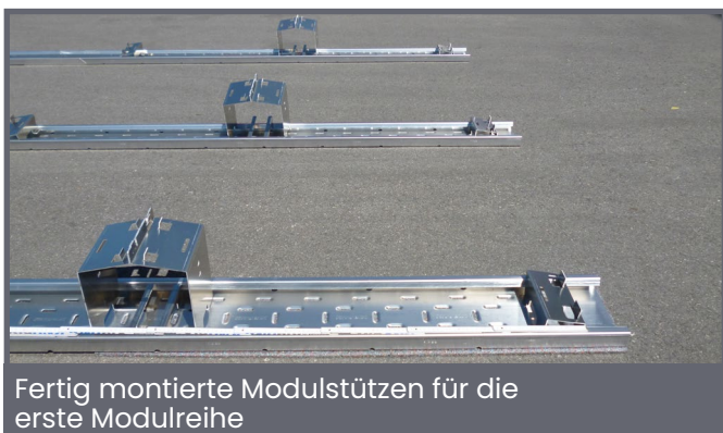
Die Befestigungsplatte ist ab 10° Dachneigung vorgeschrieben!
