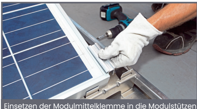
Einsetzen der Modulmittelklemme in die Modulstützen
