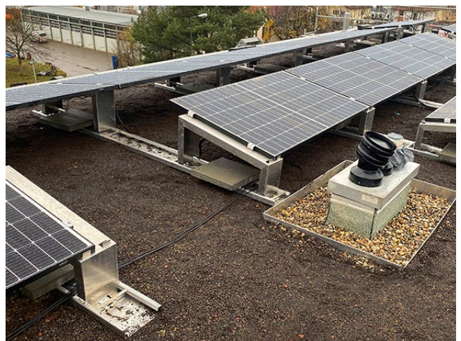
GR 10° in Ost-West A-Aufständering
