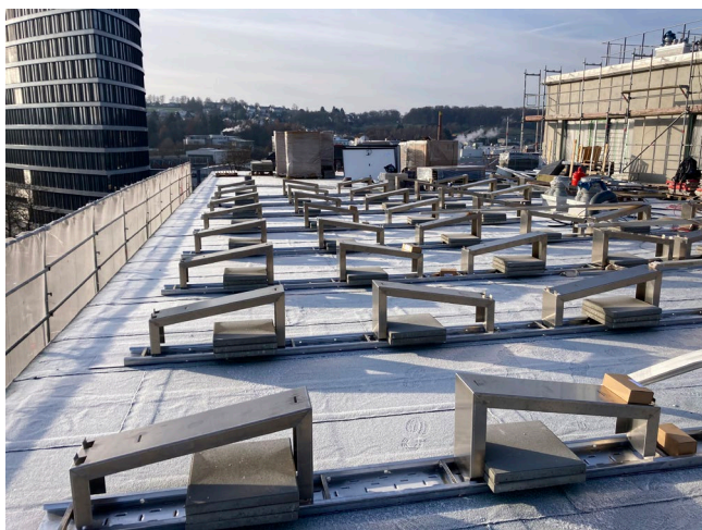
GR 10° in Ost-West A-Aufständering
