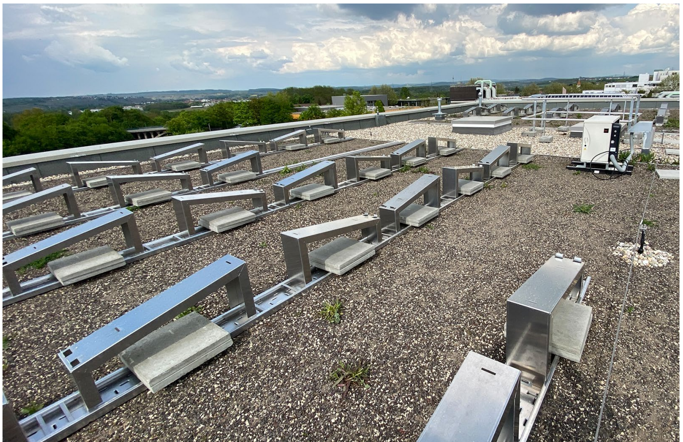
GR 10° in Ost-West V-Aufständering
